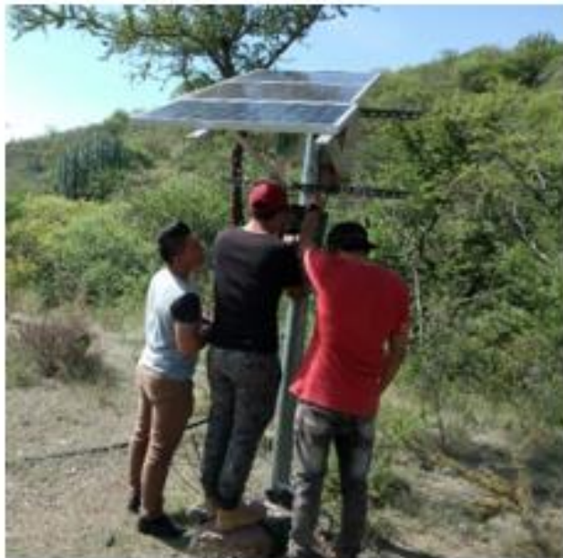
Figura 33 Desmontaje y montaje del controlador al sistema de bombeo fotovoltaico.
